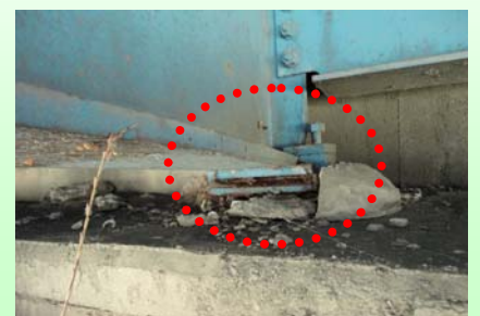
支承の損傷（沈下）
