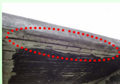
主桁の損傷（鉄筋露出）
