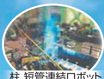
柱 短管連結ロボット
