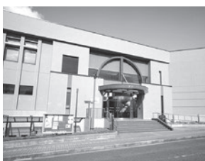
御所市文化ホール (アザレアホール)
