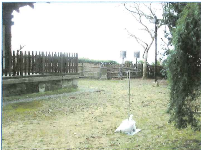
① 當麻寺西塔（左の建物が西塔）
