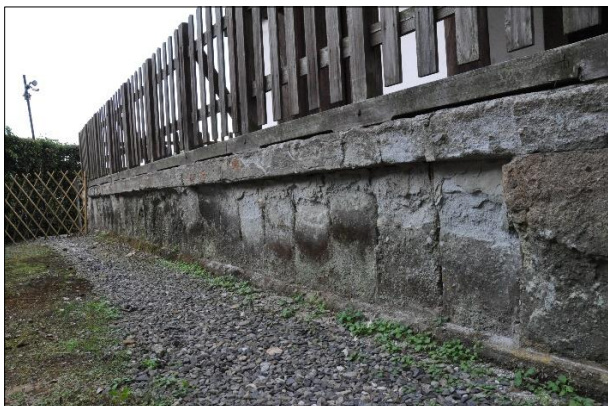
當麻寺西塔の基壇化粧石（二上山凝灰岩）の風化 (地下水の上昇・揮発と大気汚染が石材の風化を促進する)
