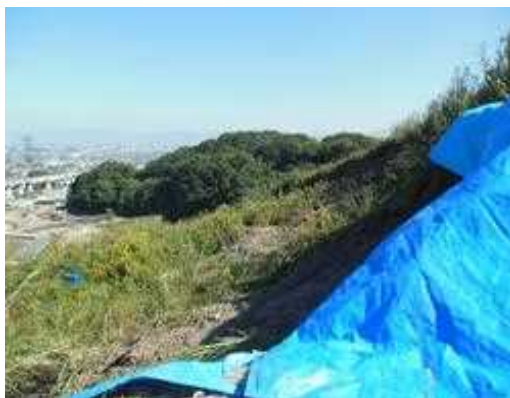
道の駅かつらぎ付近
