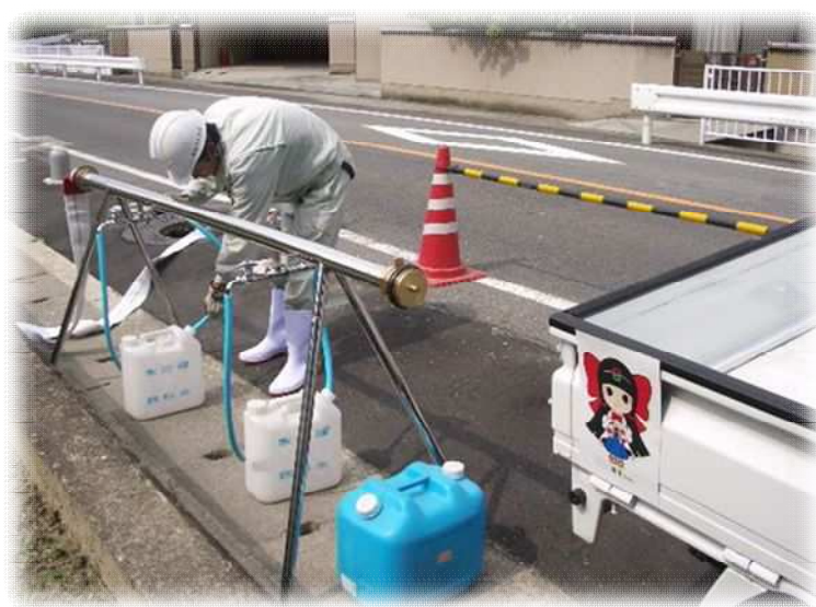
写真：応急給水栓からの給水
