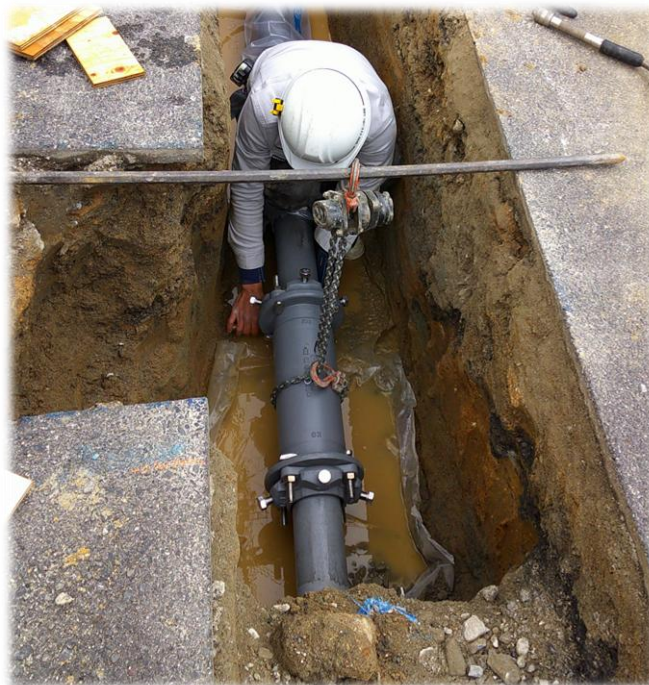
◇管路工事の様子◇
