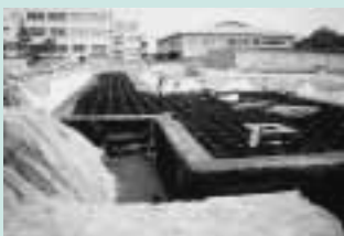
白鳳中学校の校庭貯留 (施工時のようす)
