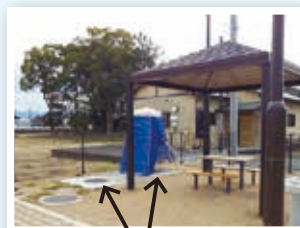
災害時トイレ (平時はマンホールのみ。災害時は写真のように使用します)
