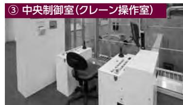
ごみクレーンを操作し、ごみを攪拌(かくはん)、均一化した後で、ごみホッパに投入します。投入されたごみは焼却炉にて焼却処理します。
