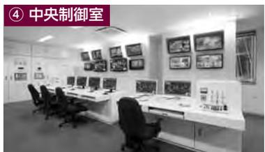
プラント設備全体の運転状況を集中監視および制御をしています。各設備はコンピュータシステムにより自動運転されます。
