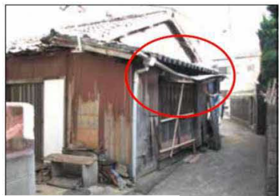
屋根が変形している、軒や雨樋が垂れ下がっており、落下飛散の恐れがある例 （屋根ふき材、ひさし又は軒）
