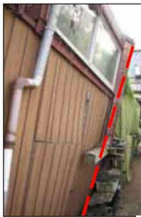
建物の傾きが明らかに確認できる例 （建築物の著しい傾斜）
