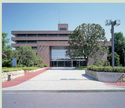
現庁舎／昭和61年～
