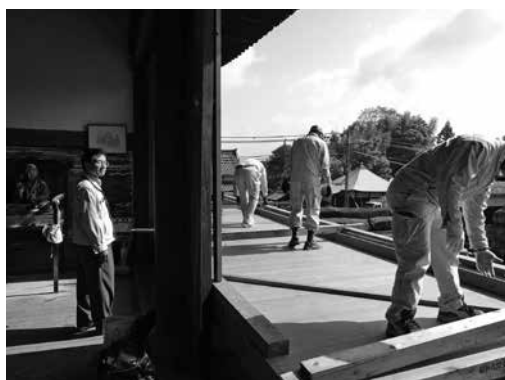
写真13 花筵場の設置
