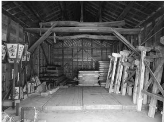
写真8 橋板と橋桁（倉庫）
