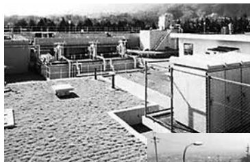
▲屋敷山浄水場
