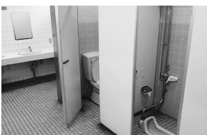
▲改修前の當麻の家トイレ
