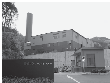
▲葛城市クリーンセンター
