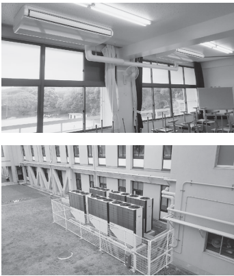
▲新庄中学校空調設備
