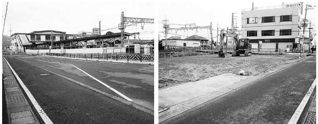
▲尺土駅前周辺の現在の様子（平成29年2月撮影）
