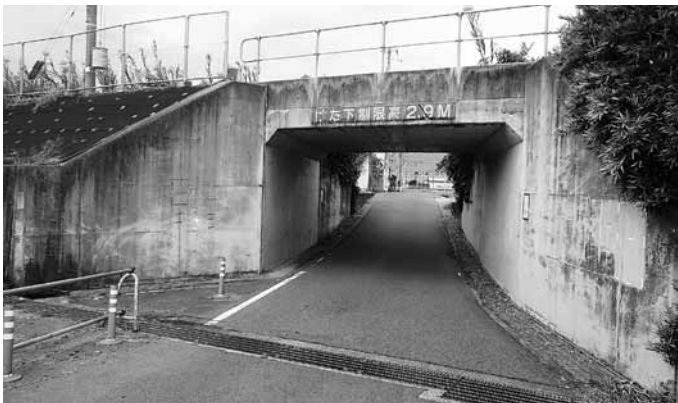
▲国鉄・坊城線JR架道橋工事現場
