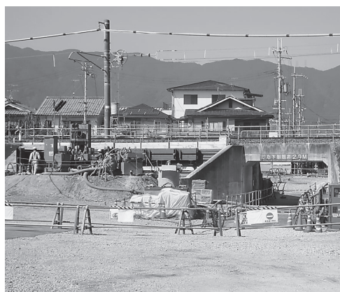
▲国鉄・坊城線J R架道橋工事現場
