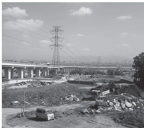
▲道の駅地域振興棟西側工事現場
