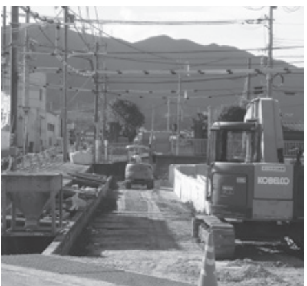
▲国道24号線東側の道路拡幅工事
