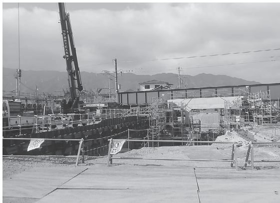
▲ JRの架道橋工事現場
