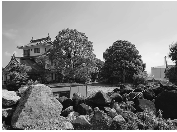
葛城市学校給食センター建設予定地(寺口地内)
