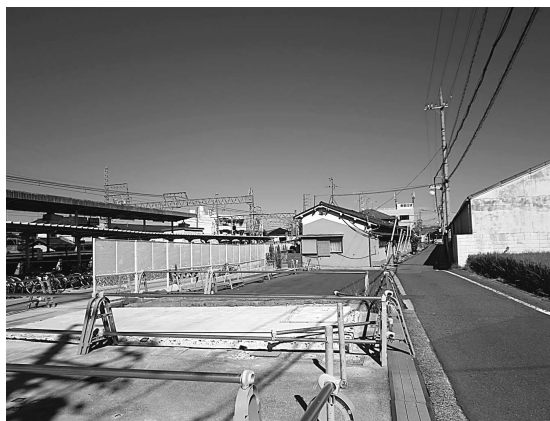
近鉄尺土駅周辺の整備状況
