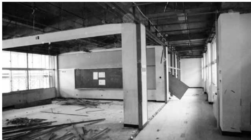
當麻小学校大規模改造工事
