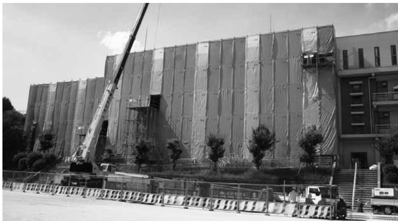
新庄中学校大規模改造工事
