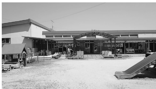
▲ 工事前の新庄北幼稚園
