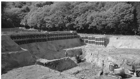
▲ 新クリーンセンターの工事の様子
