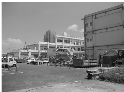
▲ 新庄北小学校増築工事現場
