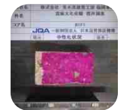
圧縮強度・ 中性化調査
