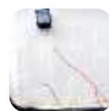
外壁のひび割れ
